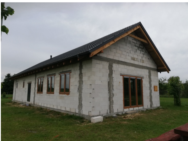
Świetlica wiejska w budowie
